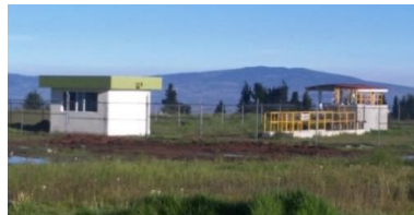
Imagen No. 6 Planta de Tratamiento – UPVT.
